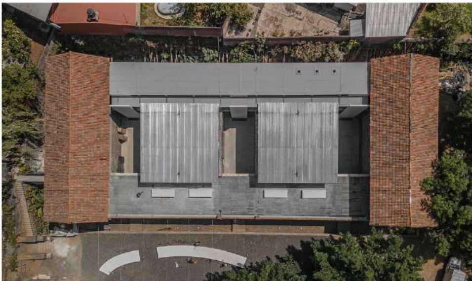
Trabajos en el edificio de las bodegas de algodón 2020-2025
